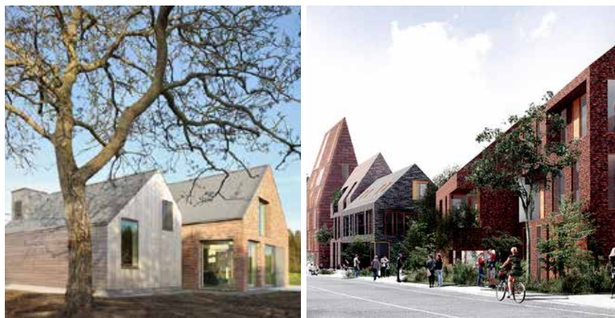
Gevel en kap zijn in materialisering en kleurstelling familie van elkaar. Daarnaast kennen de kappen verschillende hoeken.
