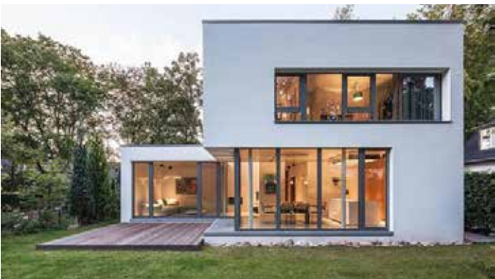
plat dak met verschil in bouwhoogtes
